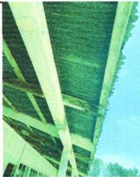
Foto 5: Requiere cambio total de láminas y costaneras en el área del corredor del módulo de 3 aulas y minibodega.
