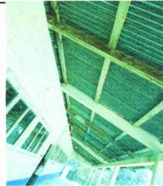
Foto 4: Área del corredor. Filtración de agua en tiempo de lluvia. Necesita cambio costaneras y láminas.
